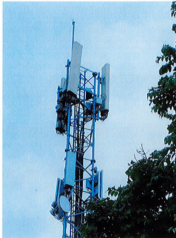
Photographie avant travaux
