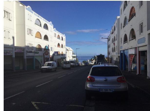
Enseignes perpendiculaires en rez-de-chaussée, avenue Paul Julius
