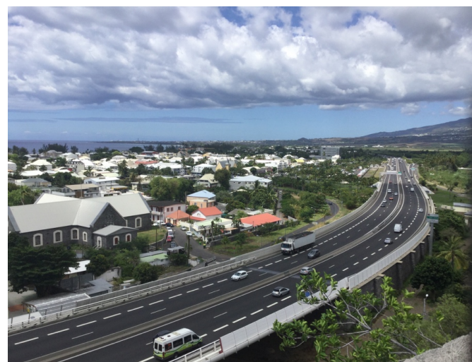
Enveloppe urbaine formée par la RN1 à l'Ouest
